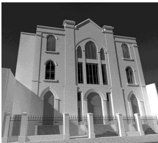
Figura 4: Fachada templo de El Olivar.
